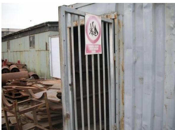
Слика 24.- Приказ просторија за чување боца са гасовима
