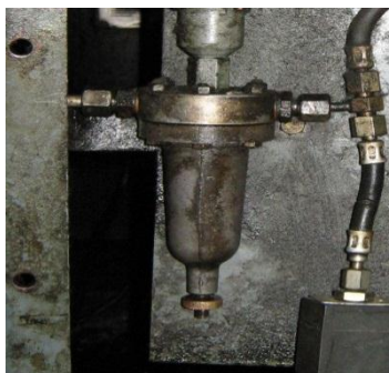
Слика 5.5 пречистач регулационог вентила
