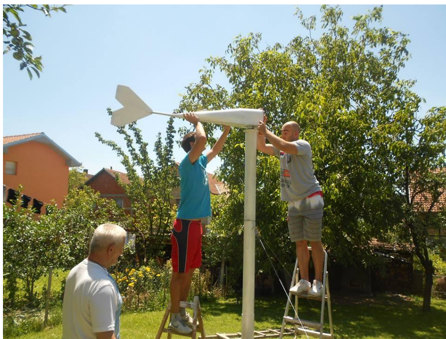
Слика 40: Постављање ветрогенератора [15]
