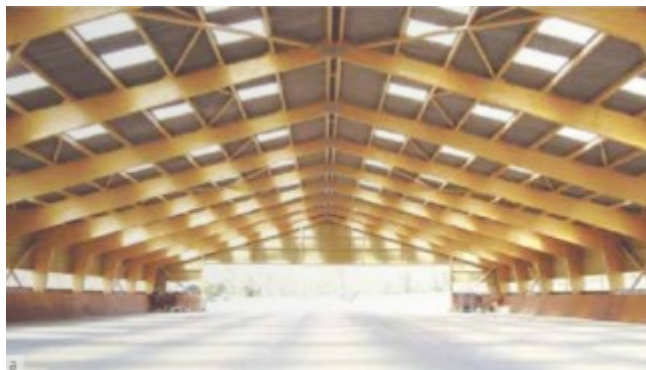
Слика 16. Трозглобна оквирна конструкција [5]
