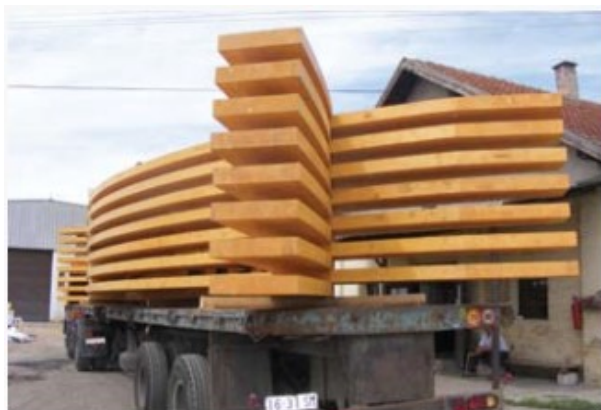
Слика 20. Транспорт носача од ЛЛД-а [18]
