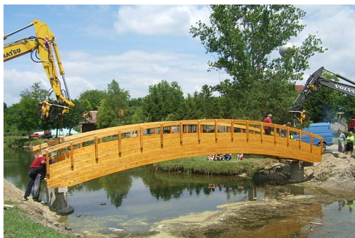
Слика 35. Монтажа пешачког моста [18]
