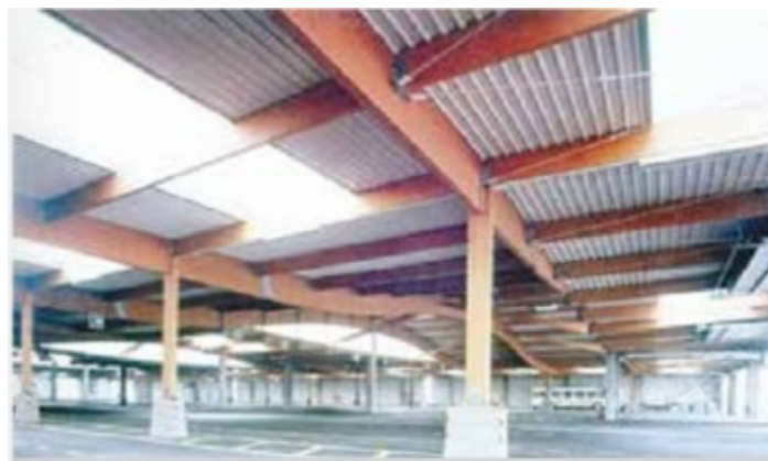
Слика 10. Герберов носач од лепљеног ламелираног дрвета [5]
