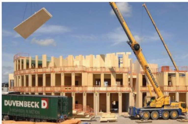
Слика 22. Подизање носача мобилном дизалицом
