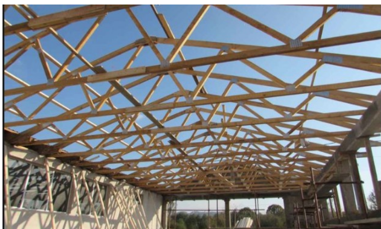
Слика 11. Решеткаста кровна конструкција од ЛЛД-а [18]
