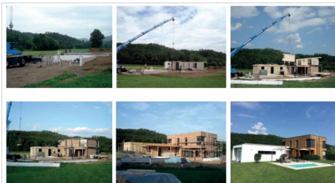
Слика 31. Изградња савременог стамбеног објекта од ББС плоча (крстасто ламелирано дрво) [25]
