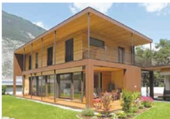
Слика 30. Пример стамбеног објекта од КЛД панела [5]
