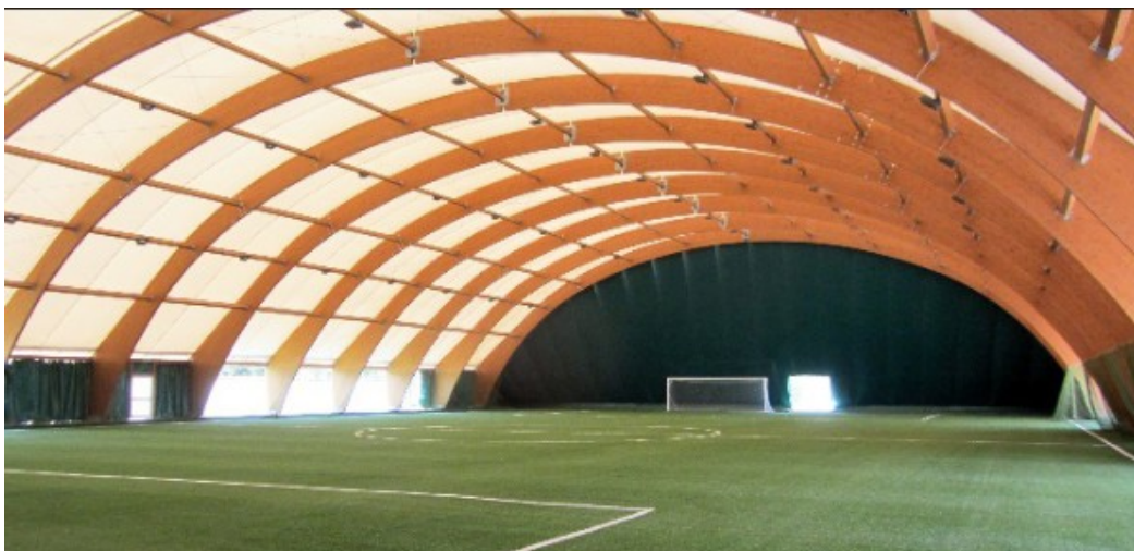
Слика 17. Двозглобна лучна конструкција [23]
