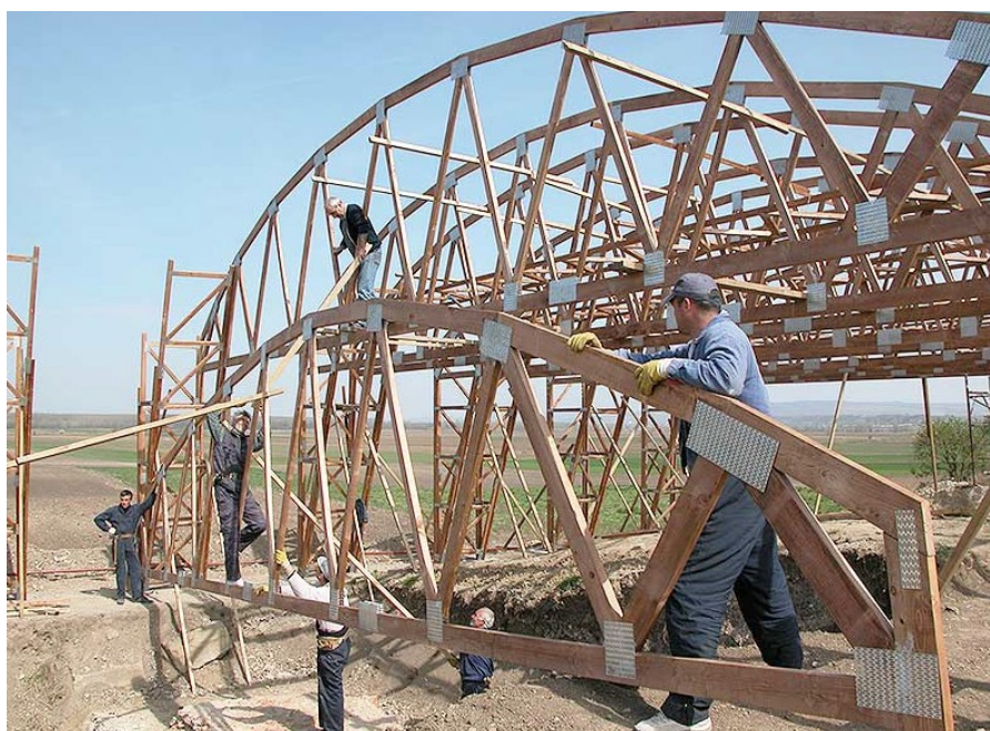
Слика 37. Монтажа заштитне конструкције [15]
