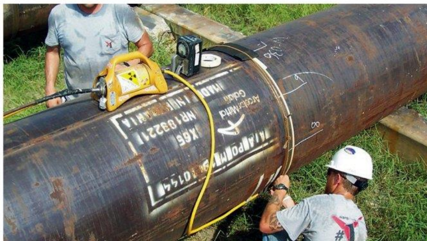
Слика 47. Испитивање цеви радиографском методом
