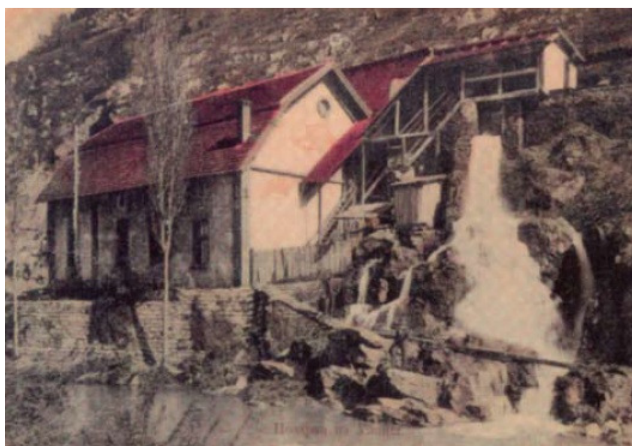
Слика 1.1. Прве хидроелектране [5]
