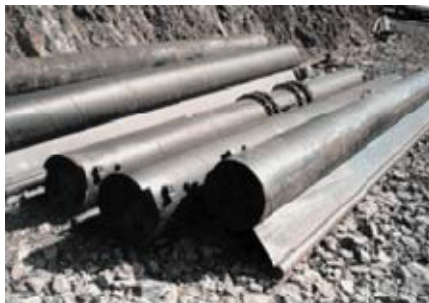
Слика 3.38. Монтажне гране
