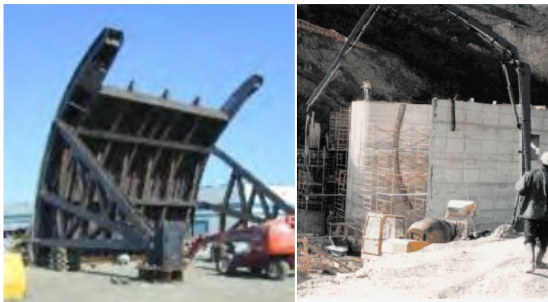
Слика 3.59. Таинтер капија (лево) и кућиште на бетонском постољу
