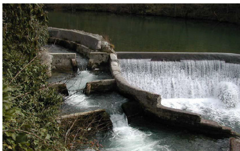
Слика 5.9. Пролаз за рибе- рустична конструкција
