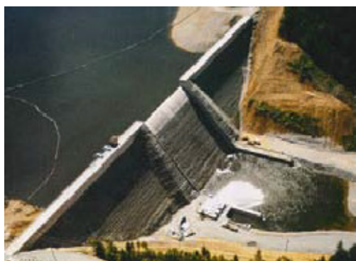
Слика 3.10. Бетонска брана
