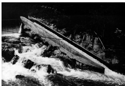
Слика 5.13. Сабирни канали и претходнице Денил пролаза за рибе
