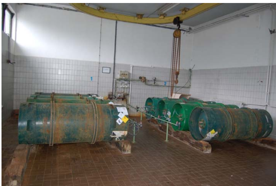
Слика 48.- Складиште хлора из којег се дозира хло по потреби
