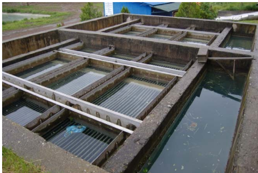
Слика 56.- Ламела за пречишћавање отпадних вода
