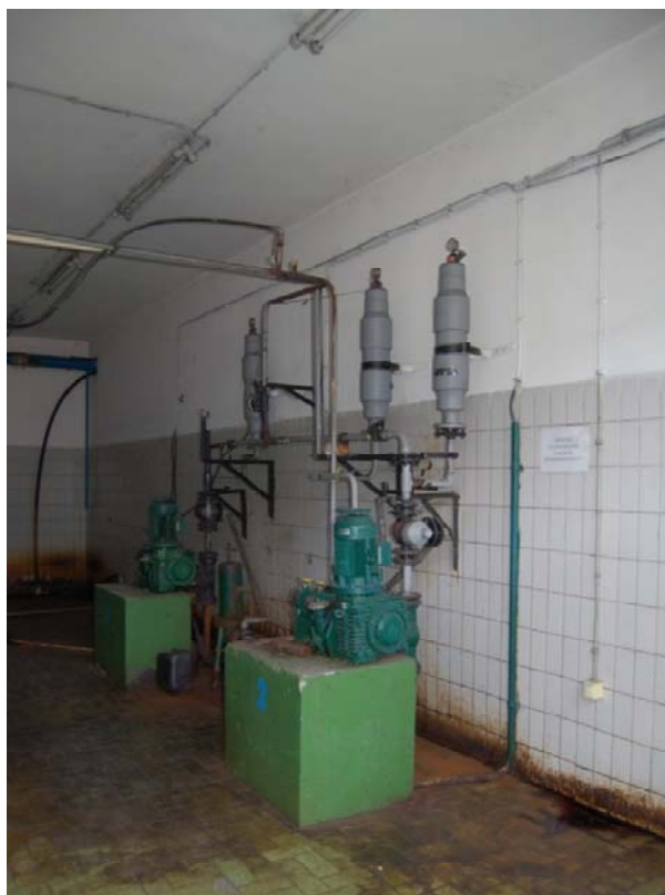
Слика 35.- Опрема за дозирање калијум пергамангата
