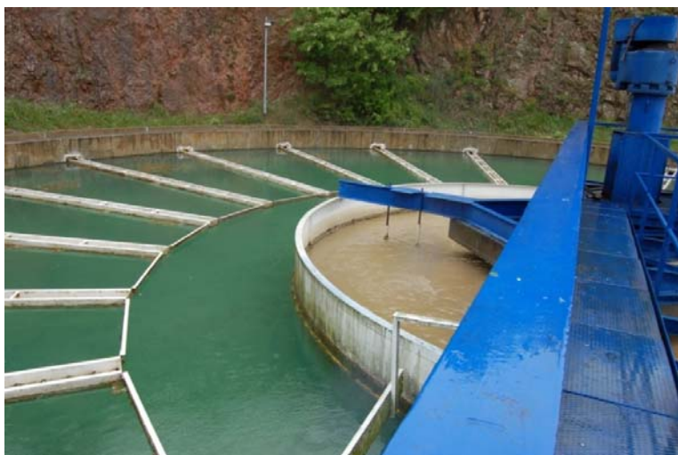
Слика 14.- Коагулатор 1 са средишњим делом у којем долази до мешања алуминијум сулфата
