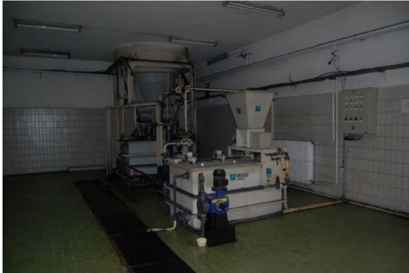
Слика 15.- Опрема за дозирање флокулата
