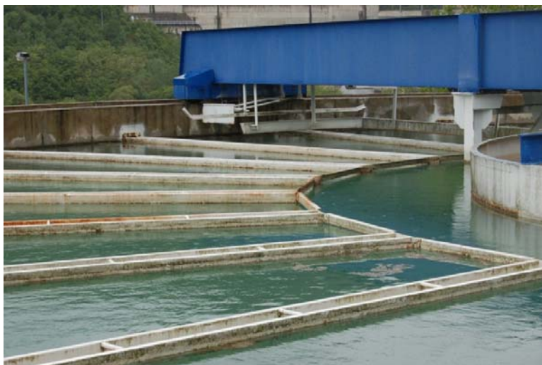
Слика 13.- Коагулатор 1 са подеоцима у којима је долази до одвајања честица
