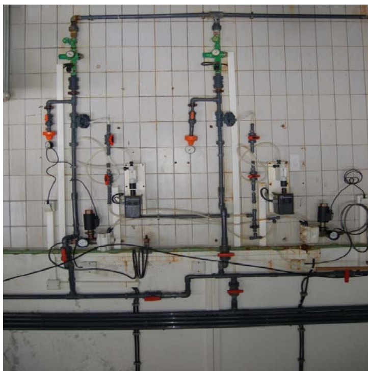
Слика 47.- Систем за регулацију хлора у коагулатору 1 и 2
