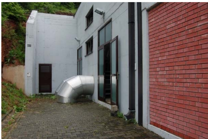
Слика 8.- Довод сирове воде у постројење за озонизацију
