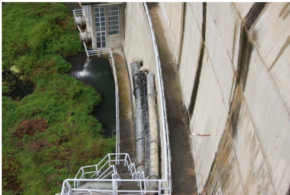
Слика 5.- Цеви захвата који се налазе на различитим дубинама
