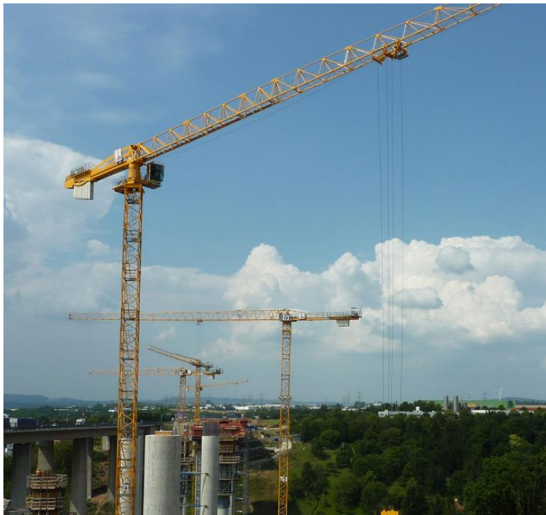
Слика 2.1 Грађевинска дизалица са покретном стрелом [3]
