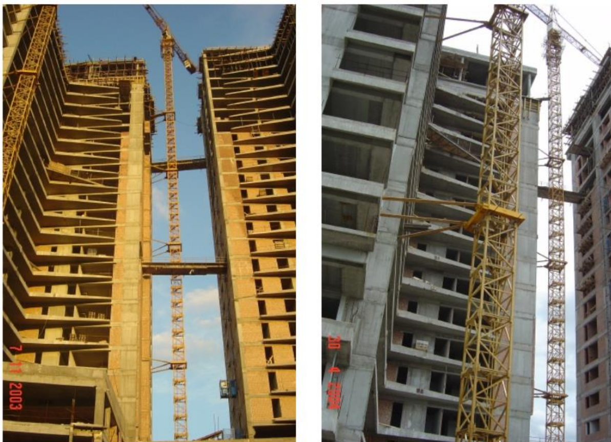
Слика 2.13 Телескопско извлачење и анкерисање за објект [3]
