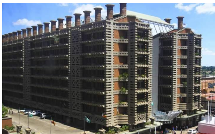
Слика 23. Спољашњи изглед зграда [21]
