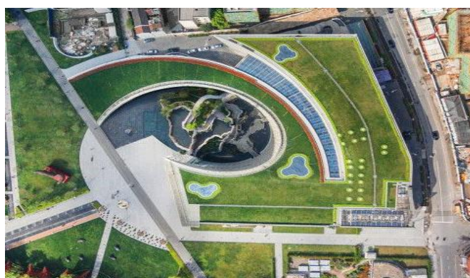
Слика 28. Поглед одозго на зелени травнати кров [25]
