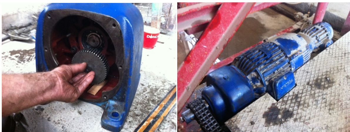
Слика 14. Монтажа репарисаног зупчаника у редуктор и пуштање у експлоатацију
