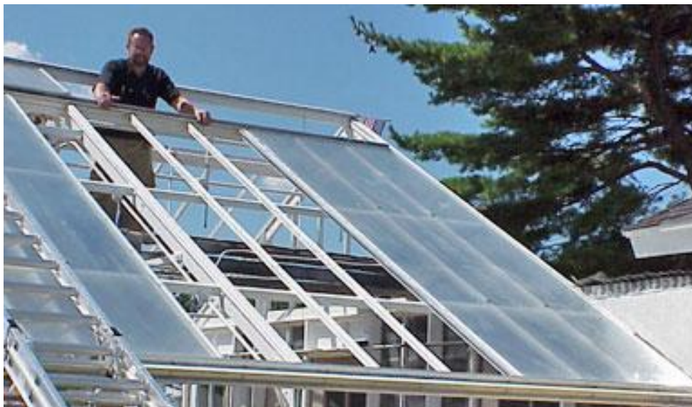
Слика 2.3 – Застакљивање стакленика
