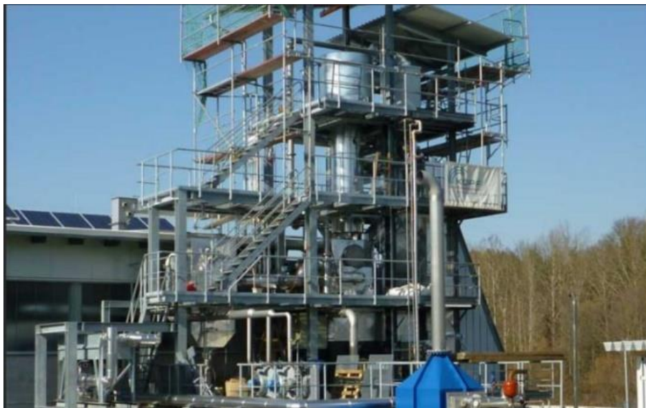
Слика 21. Постројење у Балингену [28]
