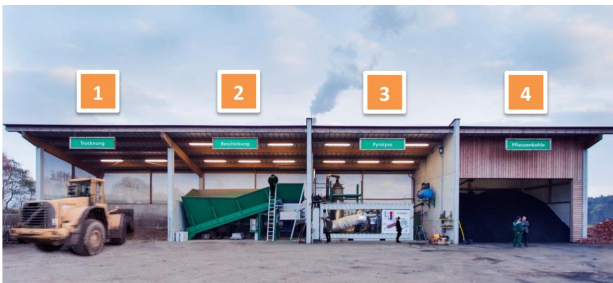
Слика 24. Изглед једног постројења за пиролизу [32]
