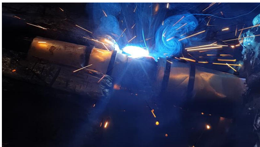
Слика 62. Наношење додатног слоја материјала (Наваривање)
