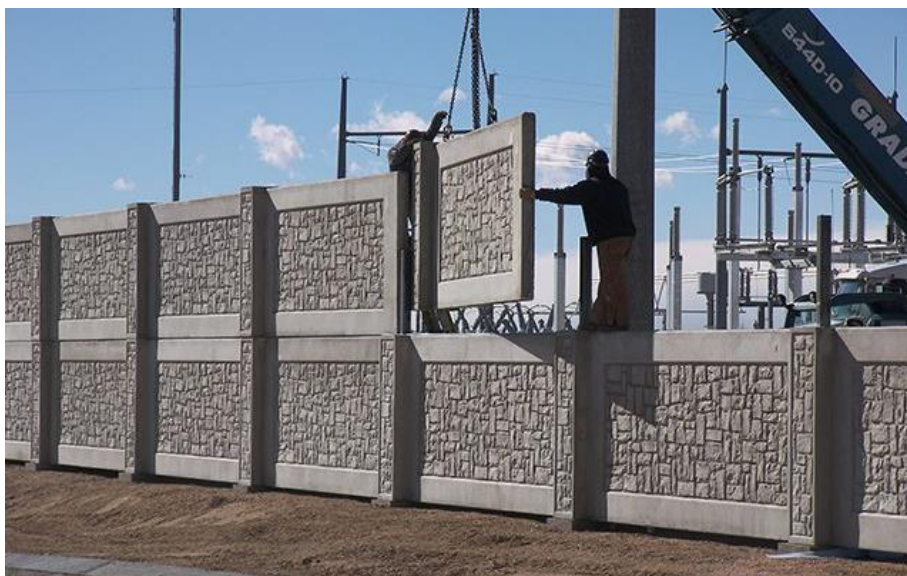
Слика 17 – Уградња унапред припремљених бетонских баријера [10]
