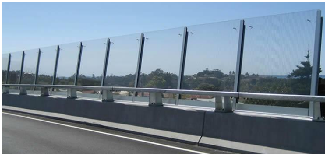
Слика 20 – Прозирна звучна баријера [13]
