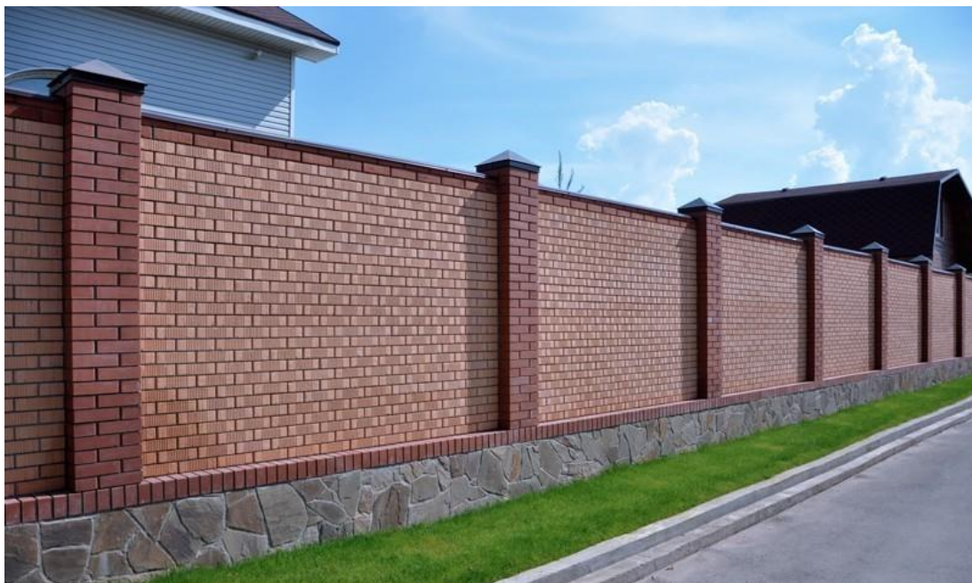
Слика 18 – Зид од опеке за апсорпцију буке [11]
