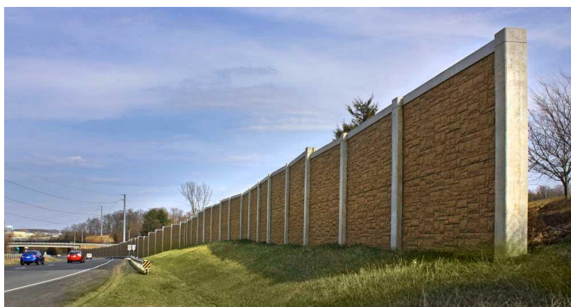
Слика 9 - Бетонски букобрани изливени на самом месту постављања [7]
