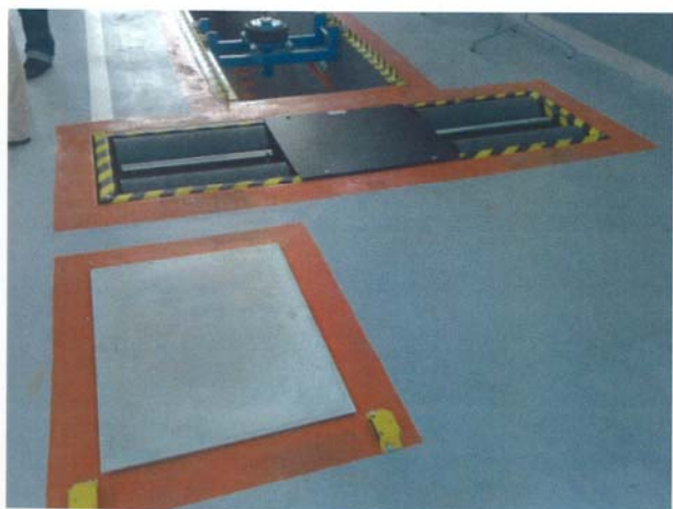
Izgled ugrađene nagazne ploče i valjaka
