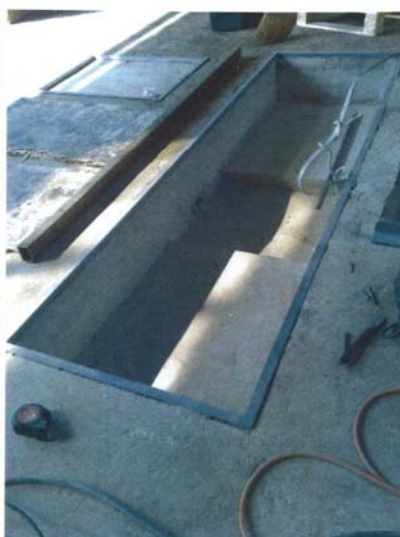
Pripremljena jama za valjke Pripremljena jama za valjke Ugradnja komandnog pulta
