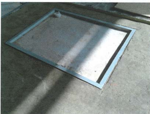
Pripremljena jama za nagaznu ploču
