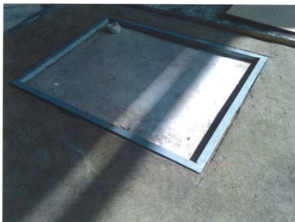
Pripremljena jama za nagaznu ploču
