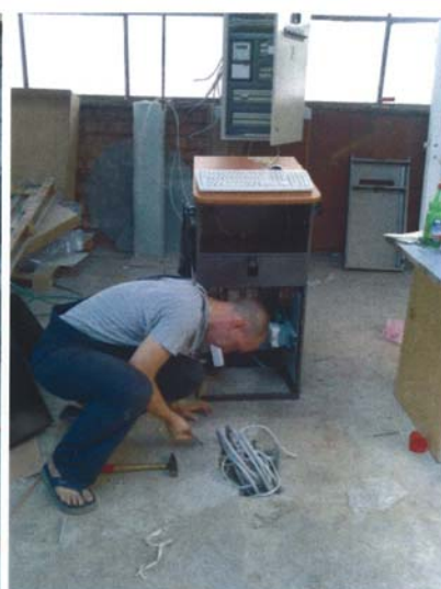
Pripremljena jama za valjke Pripremljena jama za valjke Ugradnja komandnog pulta
