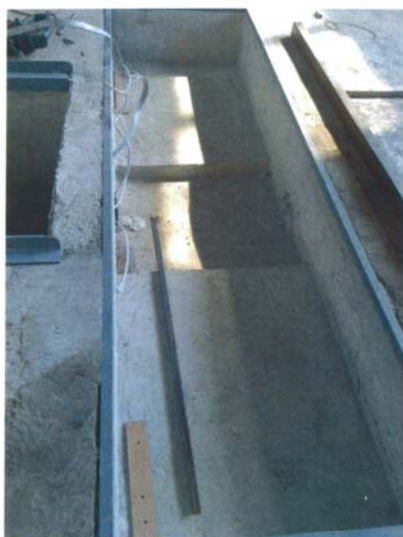
Pripremljena jama za valjke Pripremljena jama za valjke Ugradnja komandnog pulta
