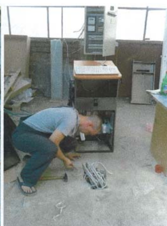
Ugradnja komandnog pulta
