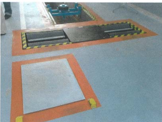
Izgled ugrađene nagazne ploče i valjaka
