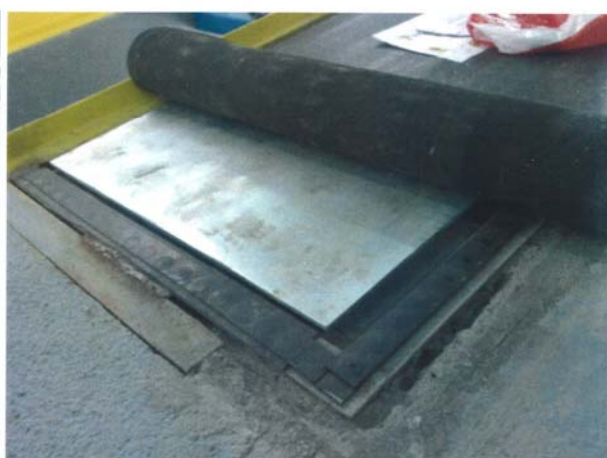
Nagazna ploča – slučaj kada je pored kanala
