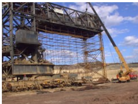
Слика 4.8: Ремонт на терену
