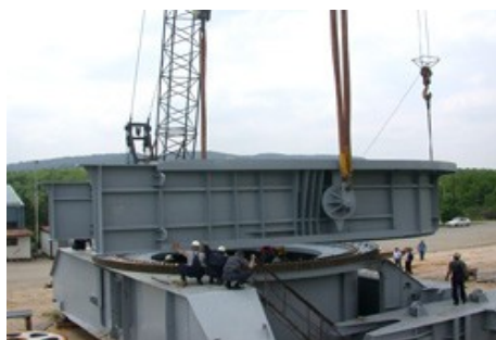
Слика 4.7: Монтажа челичне конструкције
