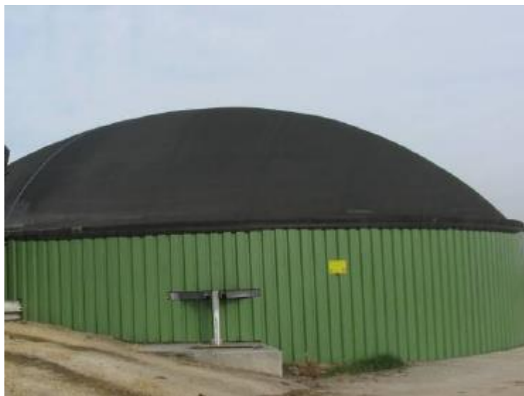
Слика 2.18 - Гасна хауба изнад ферментора
