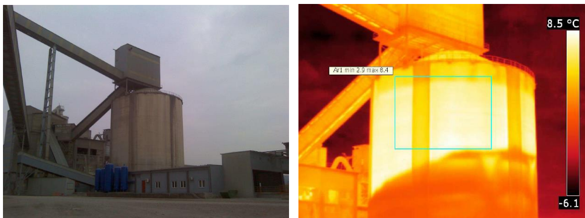
Слика 46. Одређивање нивоа клинкера у силосу применом термографије
