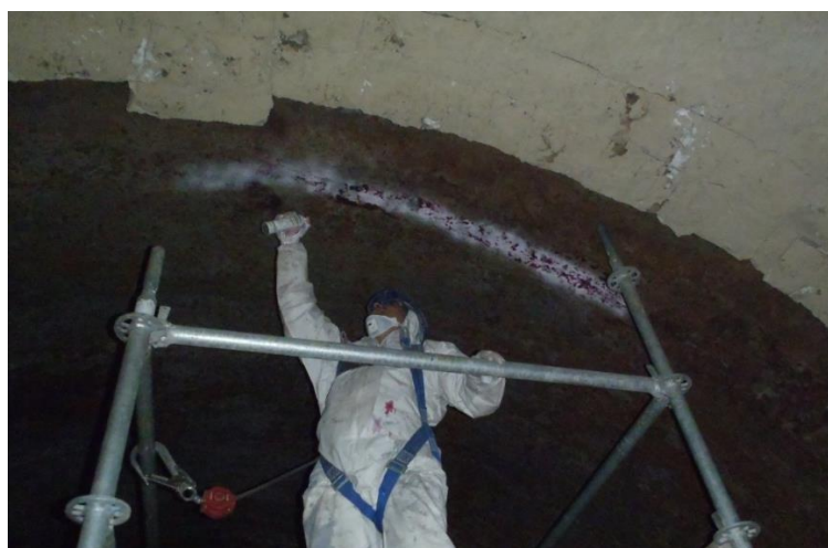
Слика 58. Наношење развијача са унутрашње стране плашта пећи клинкера.
