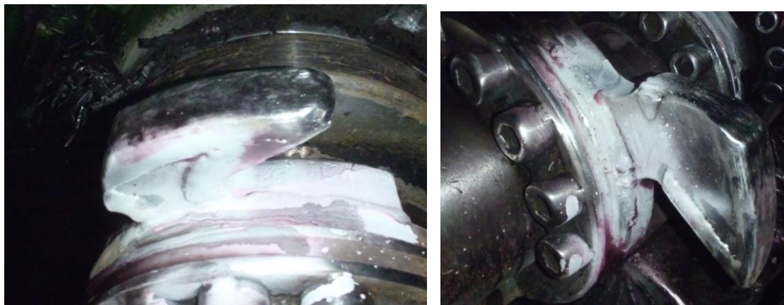
Слика 56. Извршено наношење развијача на испитивану површину (лево), извлачење пенетранта и могуће уочавање прслине на испитаној површини
