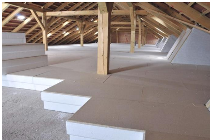
Слика 31 Изолација међуспратне конструкције тавана [12]
