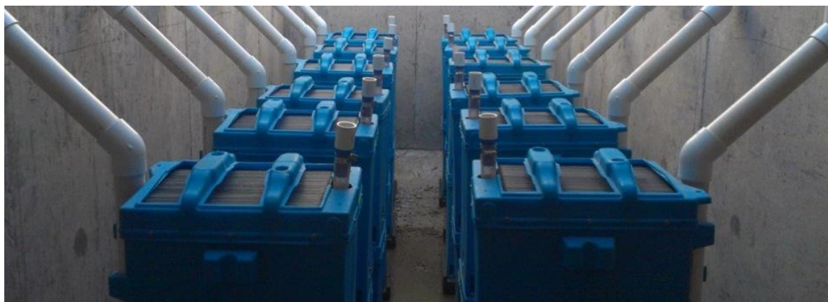
Слика 4.11. Техничко решење мембранског система
