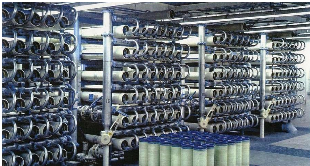
Слика 4.2.Спирално намотани мембрански модул[8]
