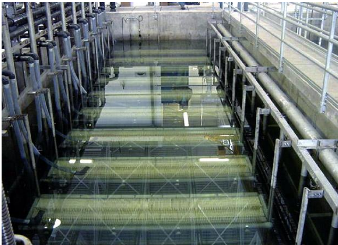
Слика 4.12. Техничко решење мембранског система
