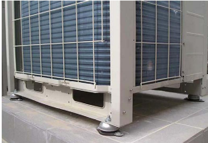
Слика 49. Амортизер за контролу удара и вибрација постављен у радни положај [10]
