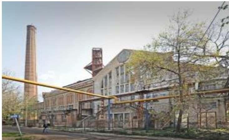
Слика 6: Централни дое предње фасаде Старе енергетике
