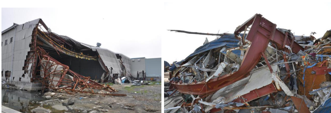
Слика 19. Ефекат земљотреса на металне конструкције, [10]
