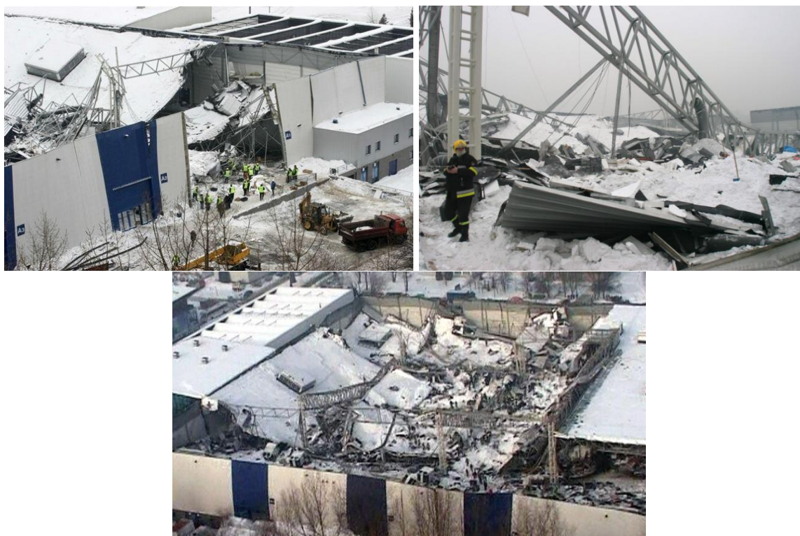
Слика 8. Срушен кров изложбене хале у Катовицама у Пољској, [8]
