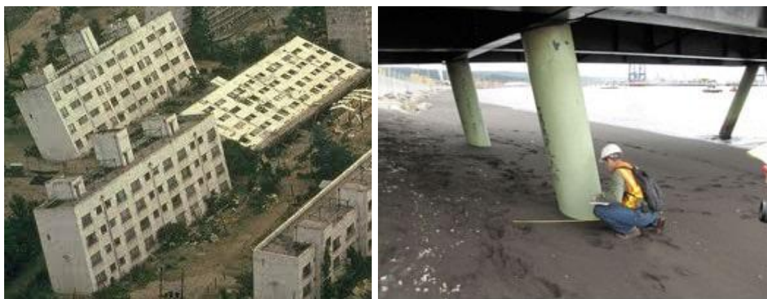
Слика 20. Последице ликвефакције тла, [11]
