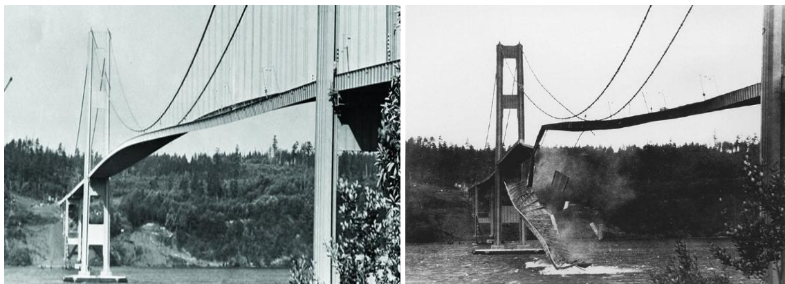
Слика 13. Осциловање и колапс моста услед дејства ветра (Tacoma Narrows Bridge), [9]
