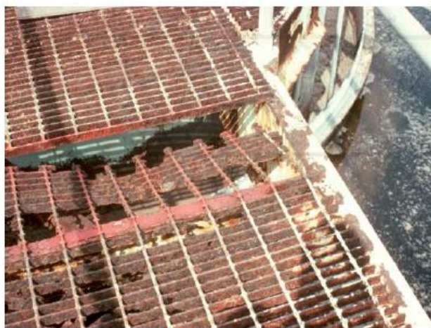
Слика 8: Дејства корозије – безбедност
