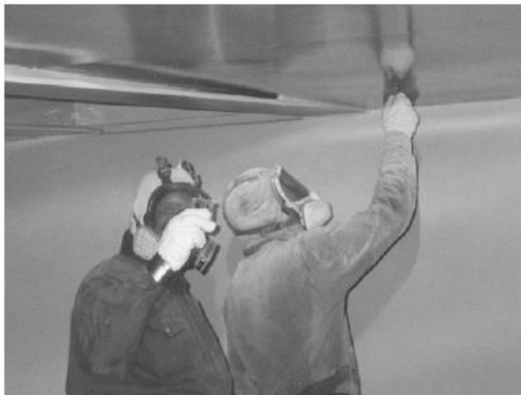
Слика 19: Мерење дебљине влажног слоја
