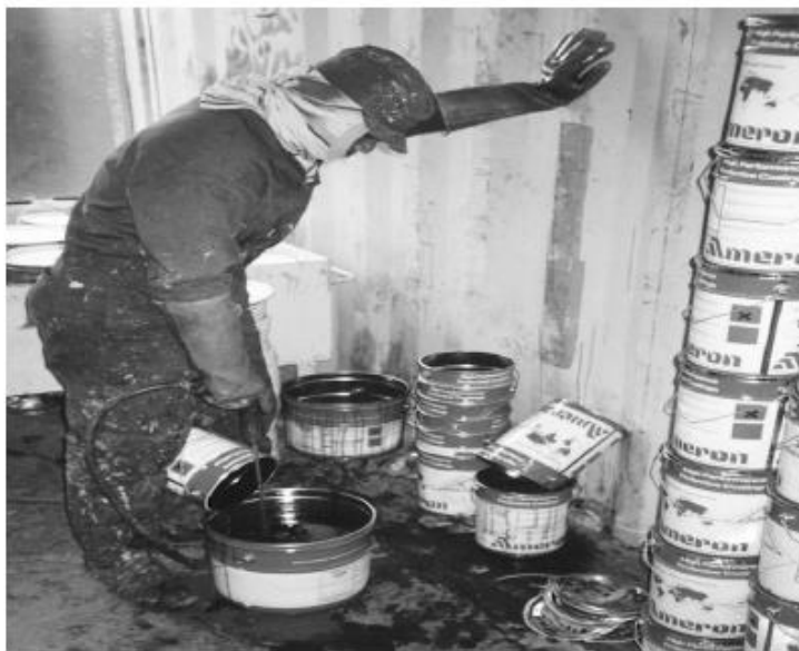
Слика 20: Мешање премаза са више компоненти
