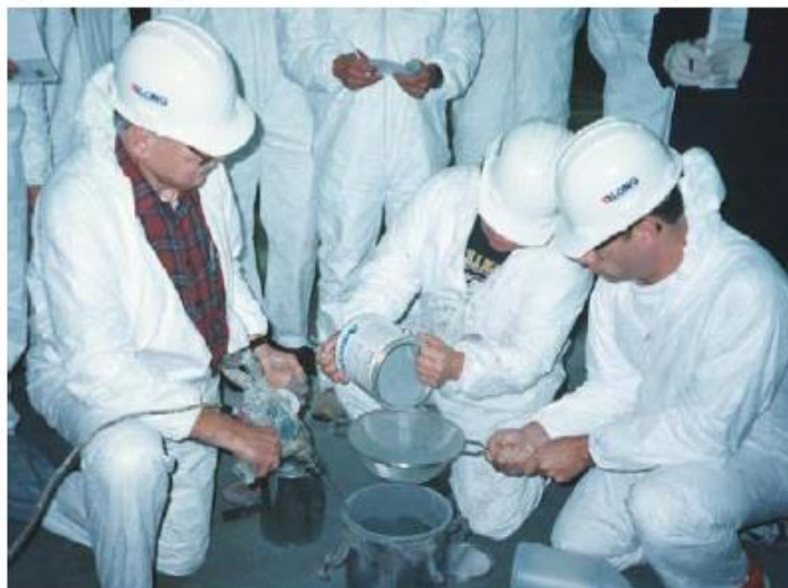
Слика 18: Процес мешања премаза
