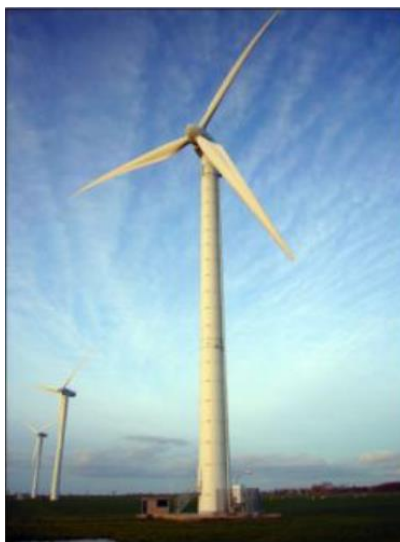
Слика 18. Ветротурбине са стубом постављеним иза лопатица [5]
