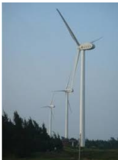
Слика 17. Ветротурбина са лопатицама испред стуба [5]
