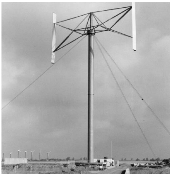
Слика 15. Ветротурбина са Н-ротором [11]
