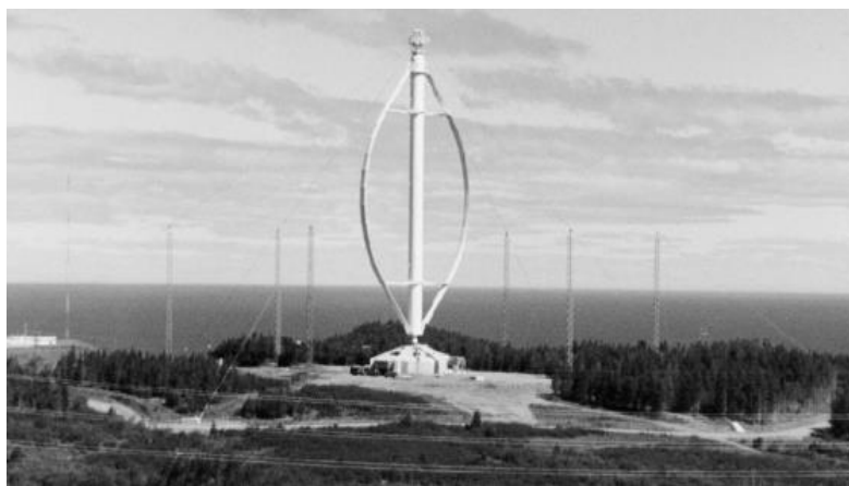
Слика 14. Мала експериментална турбина, Darrieus [11]
