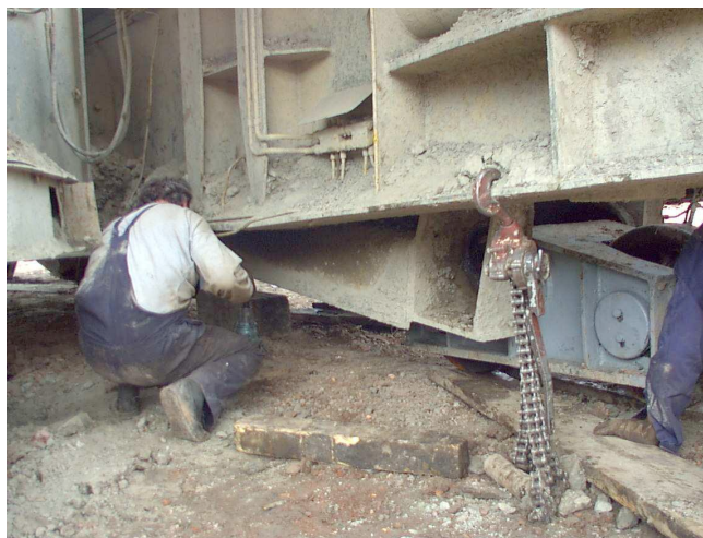
Слика 5. Демонтажа носећих колица
