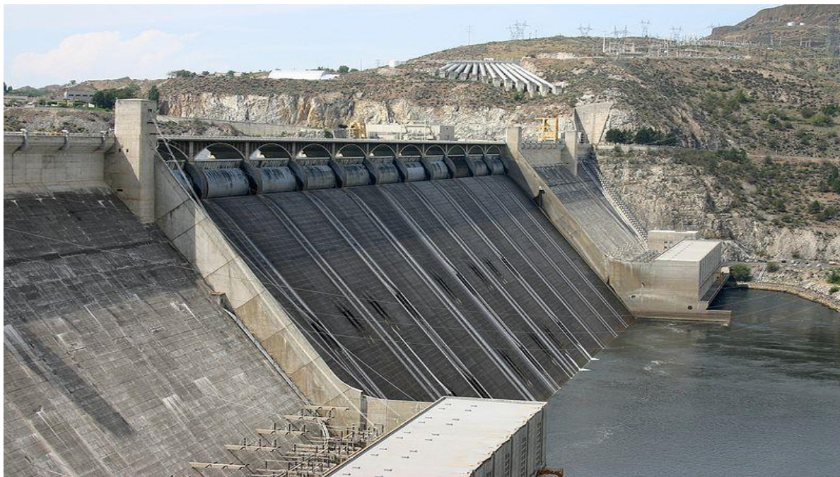
Слика 2.1 Пример бетонске гравитационе бране
