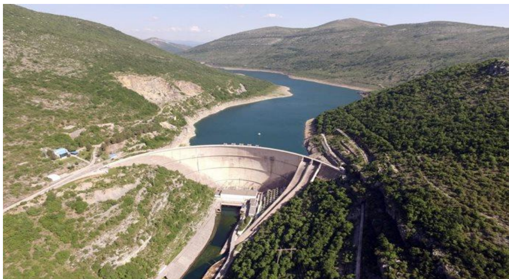
Слика 2.2 Брана „Гранчарево“ као пример бетонске лучне бране
