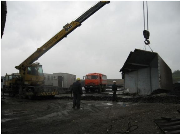
Слика 60. Спуштање заштитног лима
