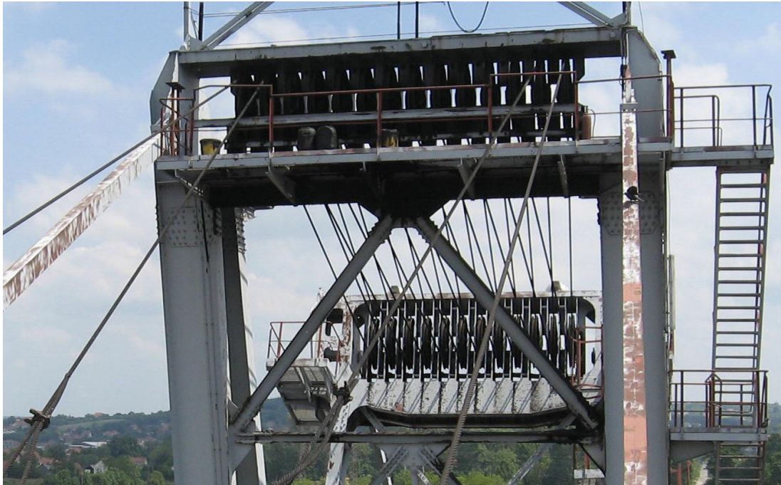
Слика 41. Челична ужад за подизање носача радног точка
