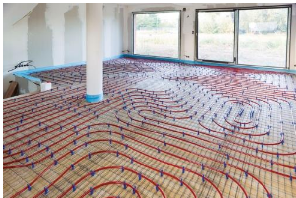
Слика 4.20 Инсталација подног грејања
