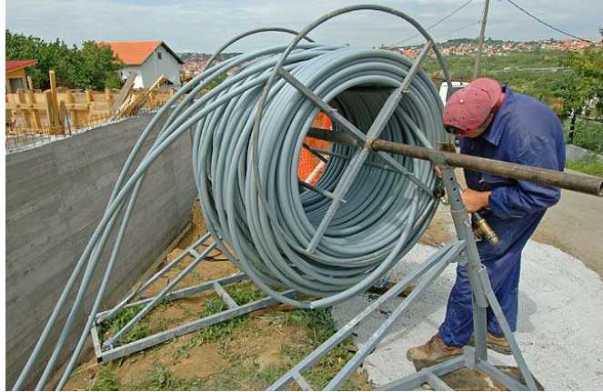
Слика 4.15 Геотермална сонда
