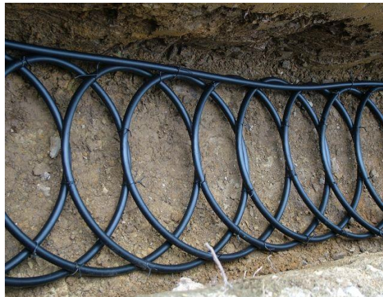
Слика 4.16 Земни колектор
