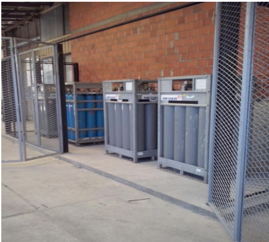
Слика 3.3.6. Гасна станица „Застава камиона“ за напајање ласера [7]
