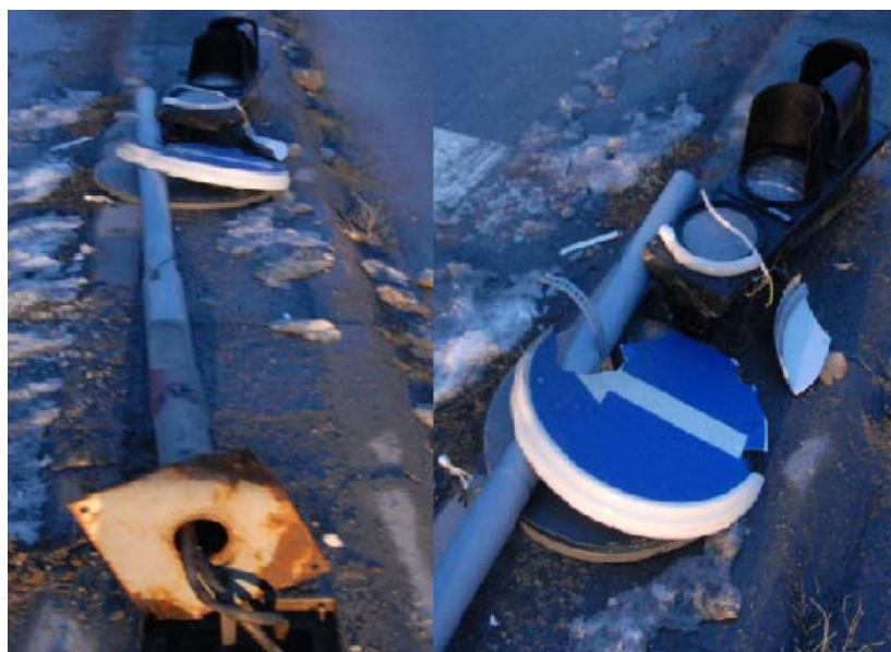
Слика 44: Оштећење опреме пута (семафора и светлећег саобраћајног знака) [3]
