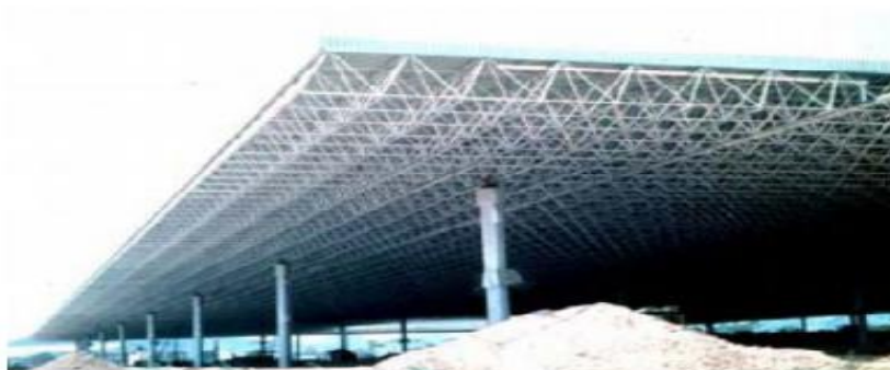
Слика 6.15 Просторно решеткасте конструкције од алуминијума
