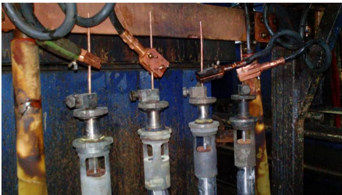
Слика 10.6. Монтирање цеви на вешалице
