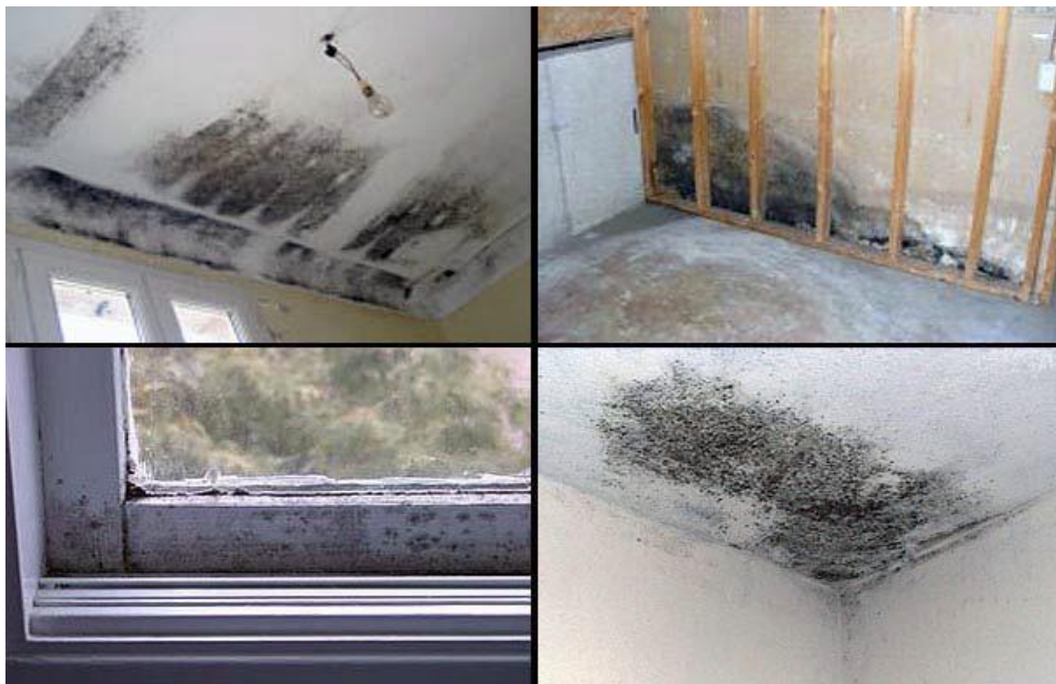
Слика 29 Формирање буђи узроковано топлотним мостовима
