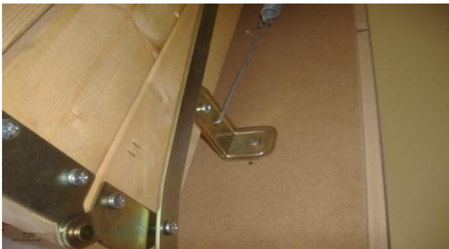
Слика 27 Шраф не пролази кроз поклопац врата
