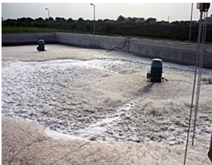
Слика 45. SBR реактор у фази аерације, Индустрија меса Carnex [27]
