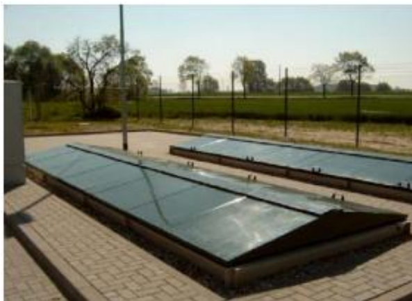
Слика 24. Поглед одозго на систем уграђен у земљу
