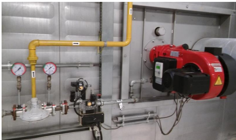
Слика 37. Изглед спаљивача за загревање сушаре спаљивањем природног гаса
