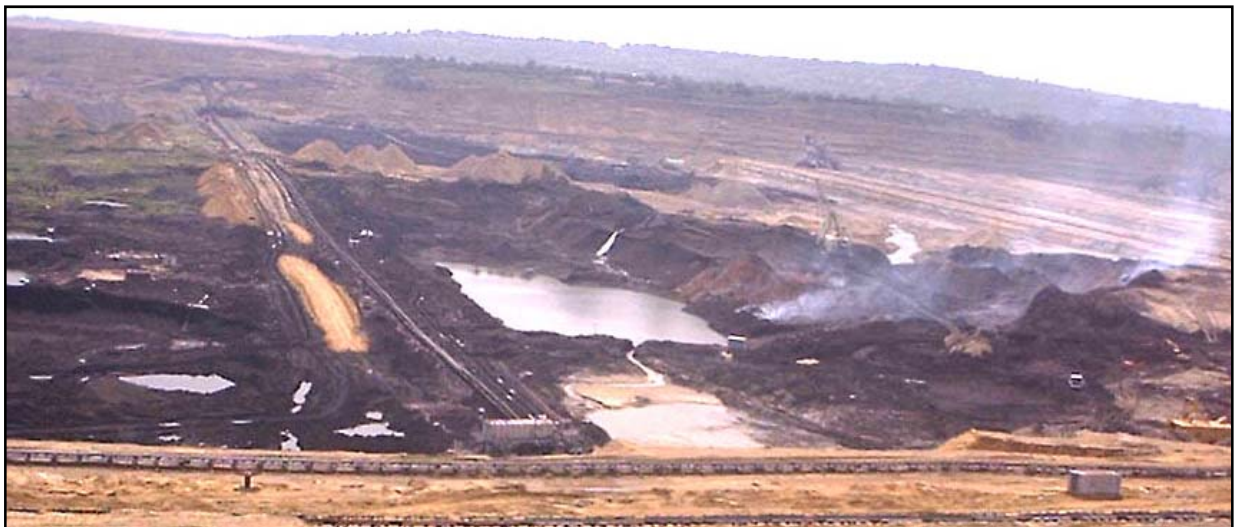
Слика 3.1. Изглед водосабирника VS-1
