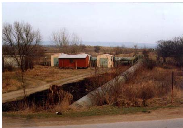
Слика 3.6. Преливна пумпна станица и одводни челични цевовод Ø 1400 mm
