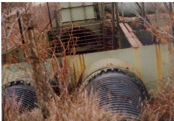
Слика 3.5. Изглед разделног резервоара са доводним (2*1200 mm) и одводним цевоводом Ø 1400 mm
