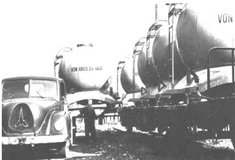
Слика 3.2. Контејнер за гасове под притиском[2]
