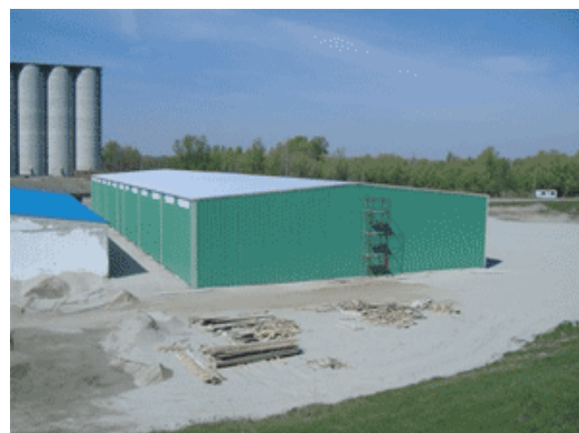
Slika 8. Hala za podno skladištenje
