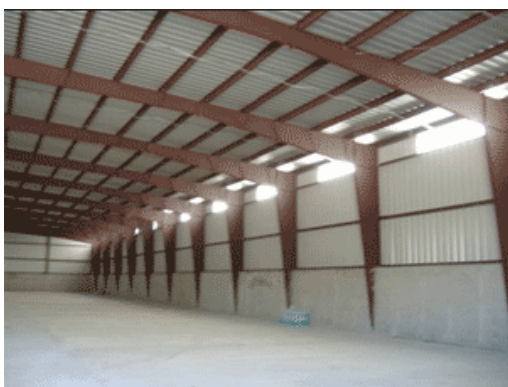
Slika 7. Izgled unutrašnjosti hale za podno skladištenje
