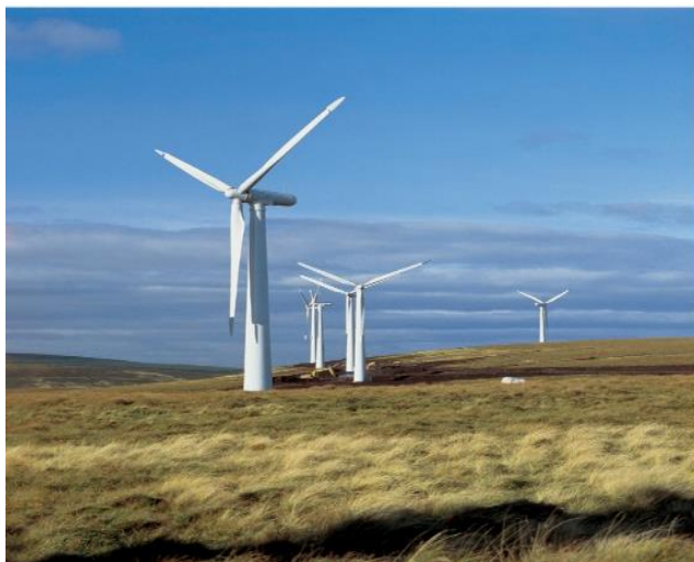
Слика 6. Примена полимерних композитних материјала ојачаних стакленим влакнима у конструкцији ветрењача. [8]
